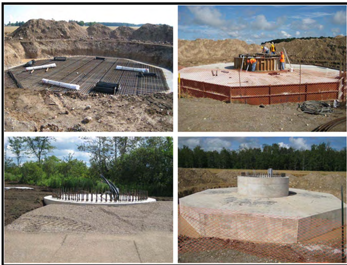
Figure 2-2 Préparation d'une fondation de masse
