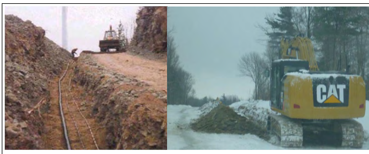
Figure 2-7 Enfouissement de lignes électriques
