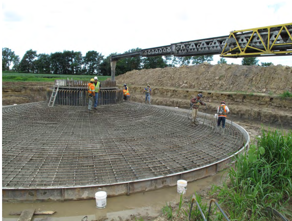
Figure 2-3 Préparation d'une fondation pour éolienne
