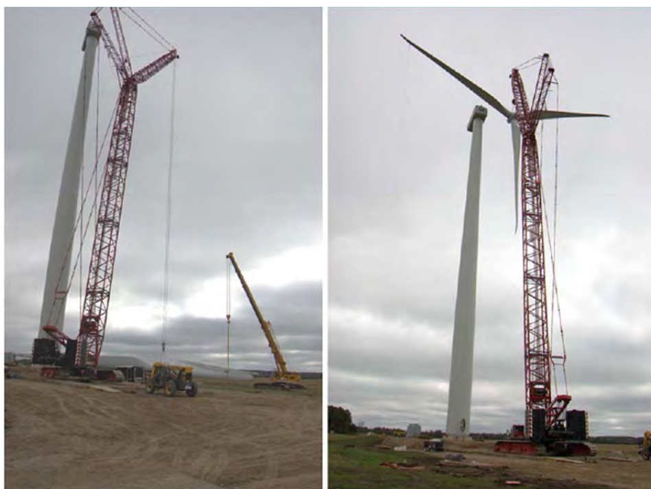
Figure 2-9 Installation du rotor d'une éolienne
